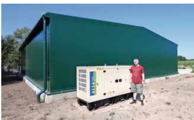
Nová ovocnářská hala u Velkých Němčic
