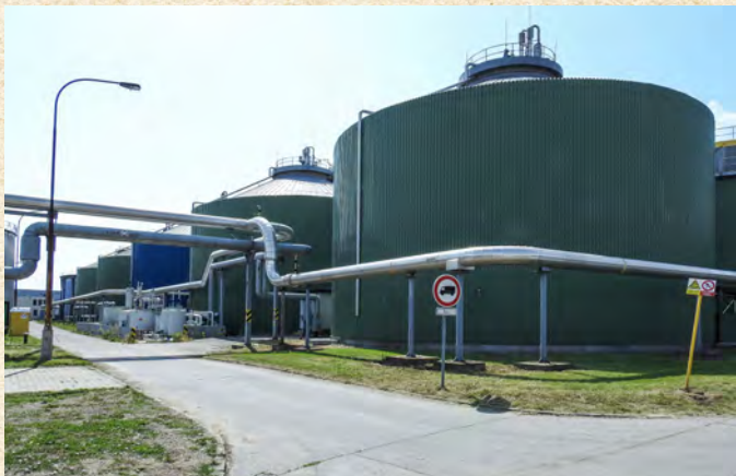
Vstupní surovinou pro výrobu biometanu jsou nádrže na vodárenský kal
