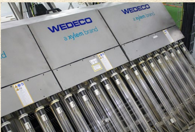
Součástí technologií je také využití UV lamp
