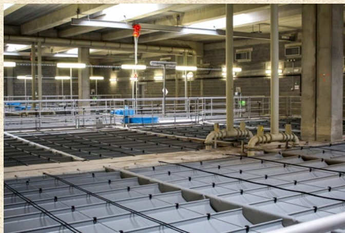
Areál Ústřední čistírny odpadních vod (ÚČOV) je běžně nepřístupný
